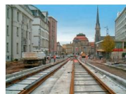
Teil 2: Ausbau der Carolastraße mit einem zweiten Gleis und Erneuerung der Fahrleitungsanlage.
