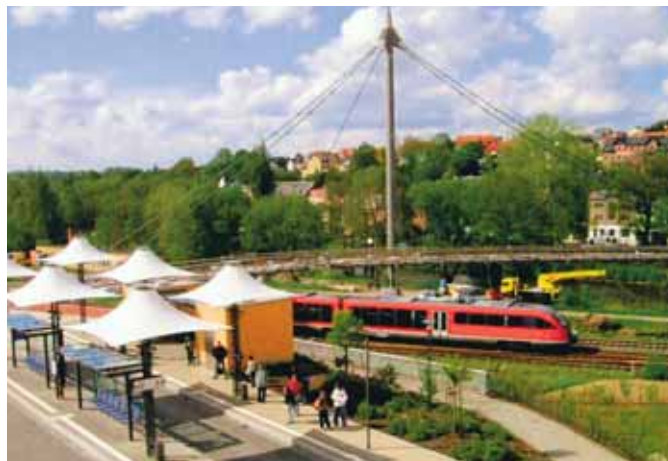
Seit dem 17. Juni 2005 können die Wilkau-Haßlauer ihre Wege durch die neue Brücke verkürzen. Foto: VMS
