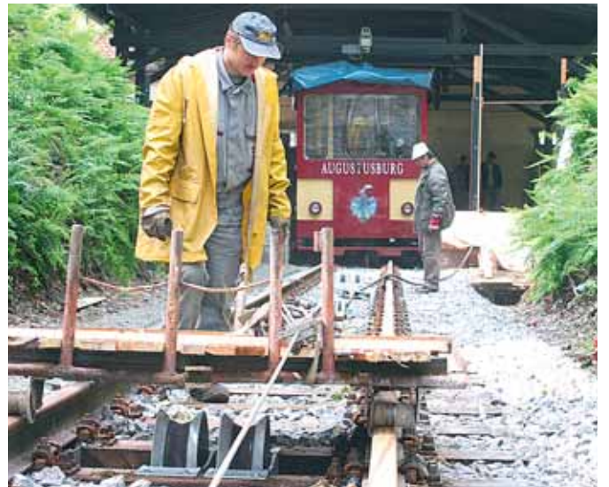
Mit dem Seilauflegen wurde die letzte Etappe der Sanierungsarbeiten eingeleitet. Foto: fb
