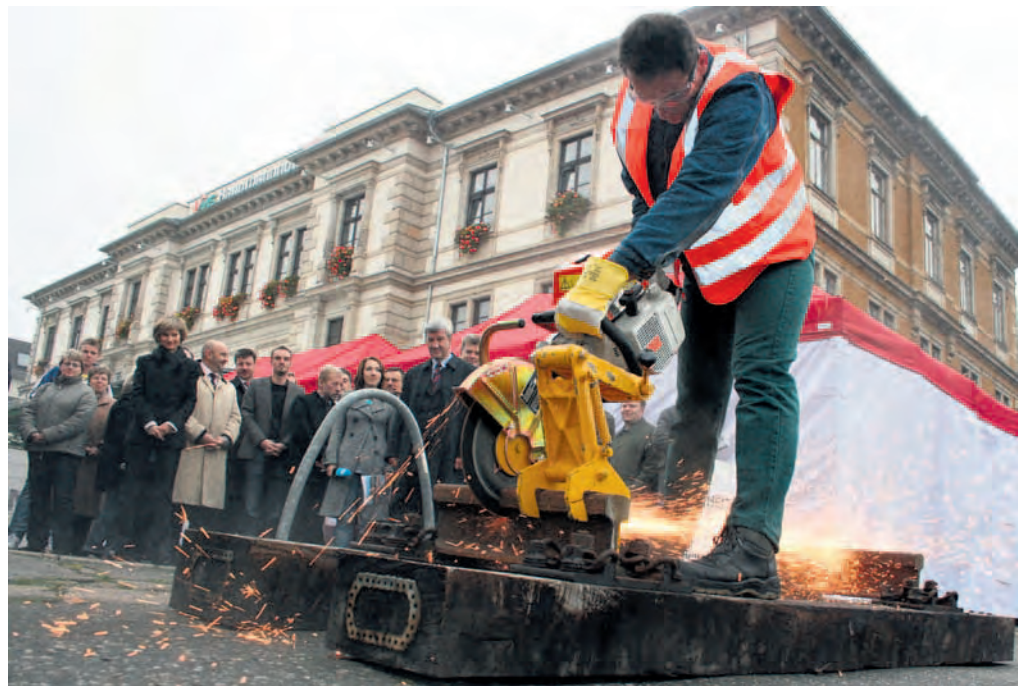
Start mit Symbolwert: Mario Beate vom Gleisbauunternehmen Heitkamp Rail trennt ein altes Gleis. Foto: fb
