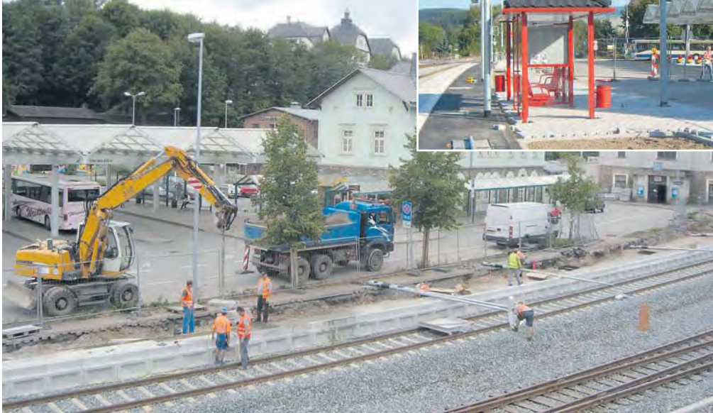
Großes Foto: Der neue Außenbahnsteig im Bau, links im Hintergrund ist der Busbahnhof sichtbar. Kleines Foto: Der fast fertiggestellte Bahnsteig mit neuem Wartehäuschen direkt neben dem Busbahnhof.
