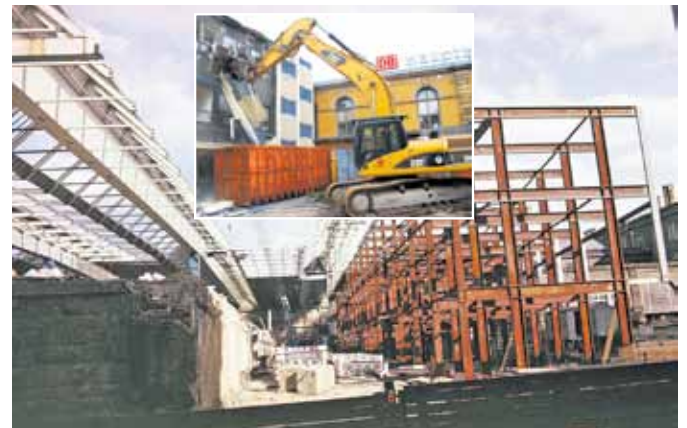
So ähnlich wird das Querbahnsteiggebäude nach vollständiger Entfernung der Außenhülle aussehen. Quelle: W. Kluge
