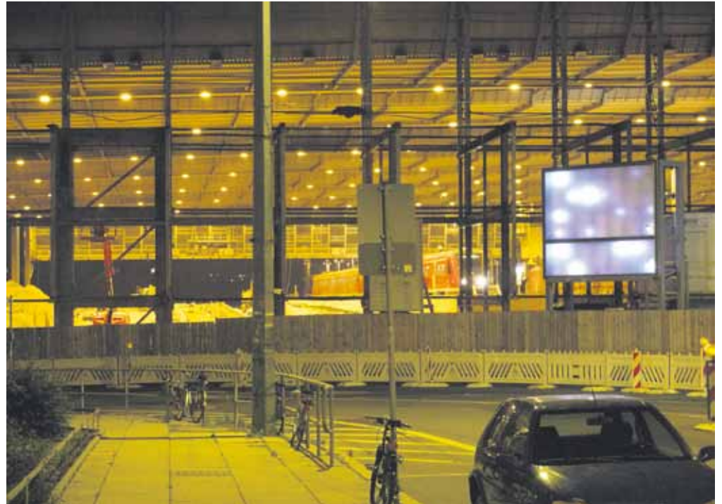
Die neue Fassade wird im Dunkeln hinterleuchtet. Foto: Architekturbüro GRUENTUCH ERNST ARCHITEKTEN
