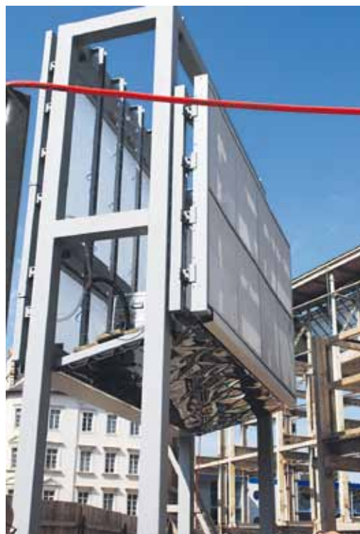
Die Unterseite der Fassade wird in Großschindeltechnik realisiert. Foto: VMS
